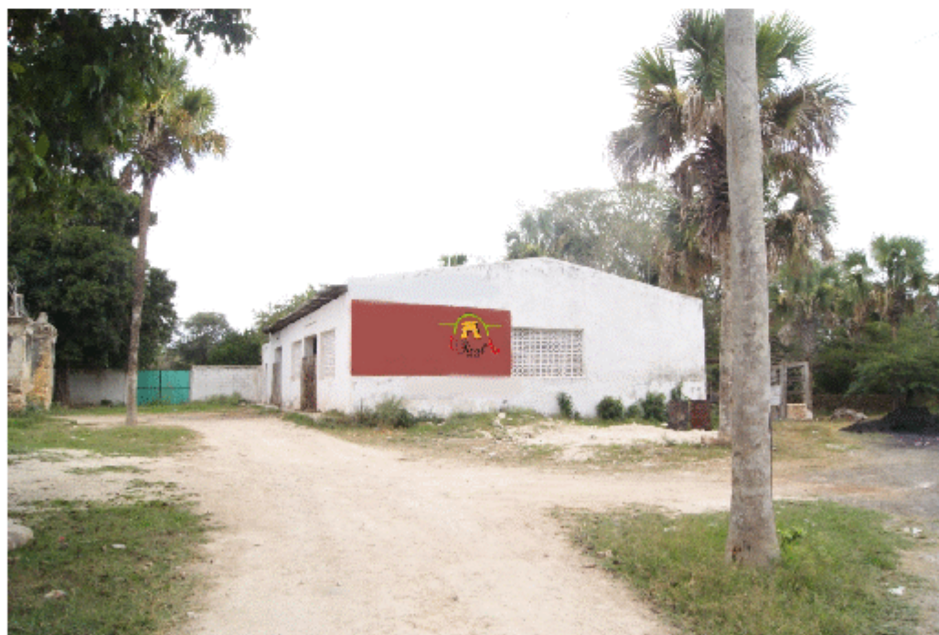
RASTRO MUNICIPAL CALLE 33 X 32 Y 34 BARRIO DE SAN ROMAN
