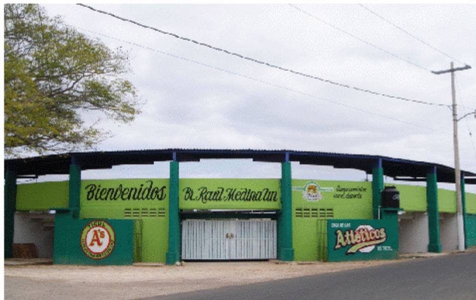
CAMPO DE BEISBOL RAUL MEDINA UN, CALLE 11 X 22 Y 20 BARRIO DE GUADALUPE
