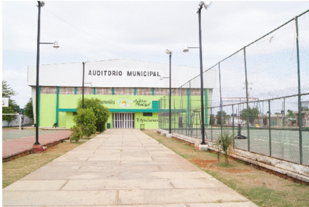
AUDITORIO MUNICIPAL CALLE 11 X 22 Y 20 BARRIO DE GUADALUPE
