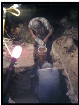
Trabajos en la red de suministro del Agua Potable Septiembre de 2010
