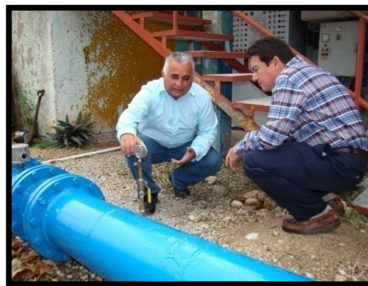
Supervisión a la planta del agua potable 13 de enero de 2011
