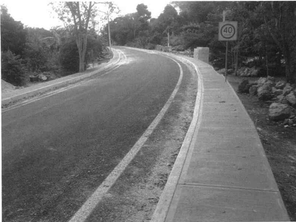
CALLE TERMINADA DE LA COMISARIA DE TZEAL
