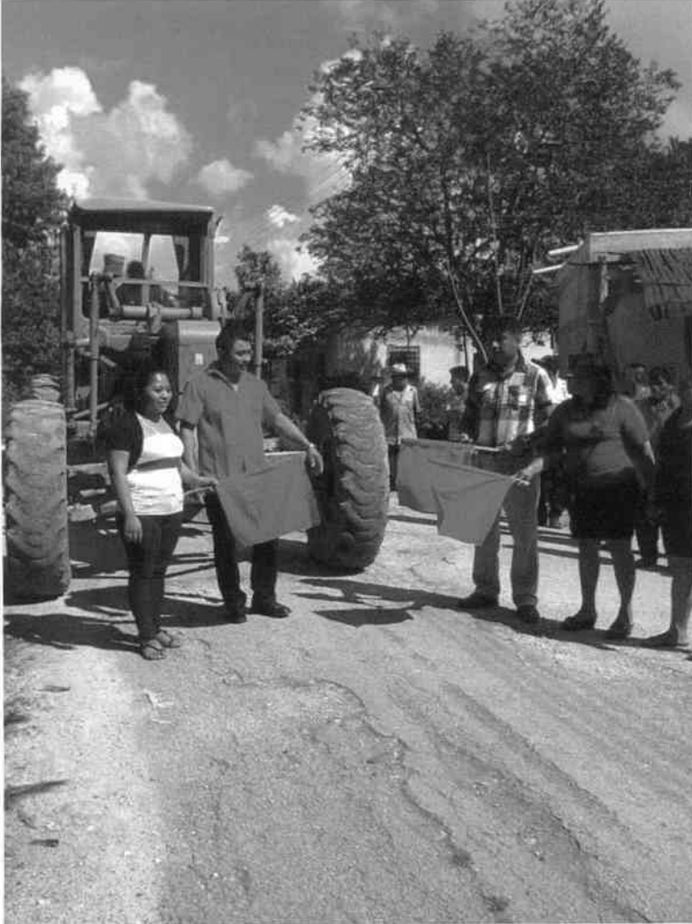
BANDERAZO DE INICIO DE OBRAS DE REPAVIMENTACION DE CALLES
