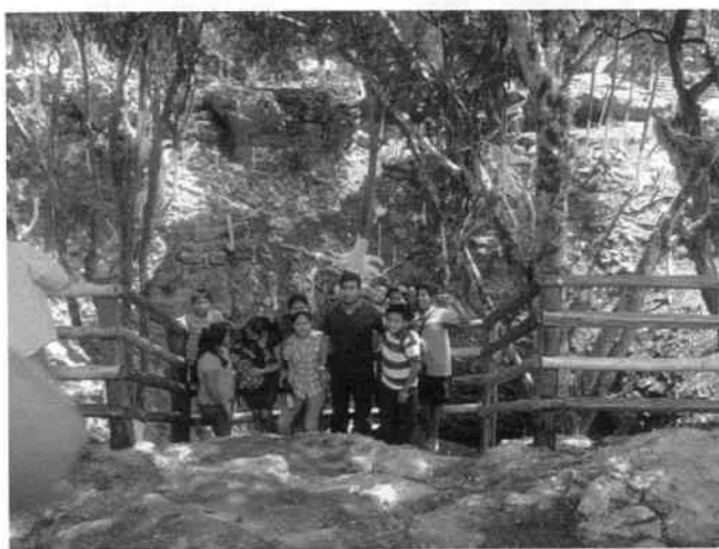
LIMPIEZA Y ACONDICIONAMIENTO DEL CENOTE UBICADO A UN COSTADO DE LA IGLESIA PARA ACCEDER A LA ENTRADA DEL CENOTE
