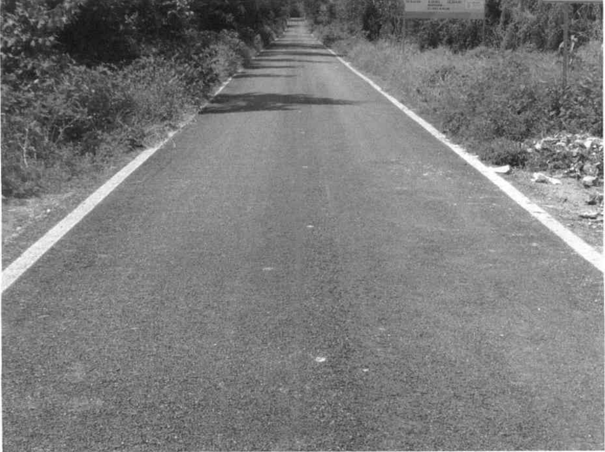
REVAMIMENTACION DE LA CARRETERA KAUA-TZEAL POR INCAY
