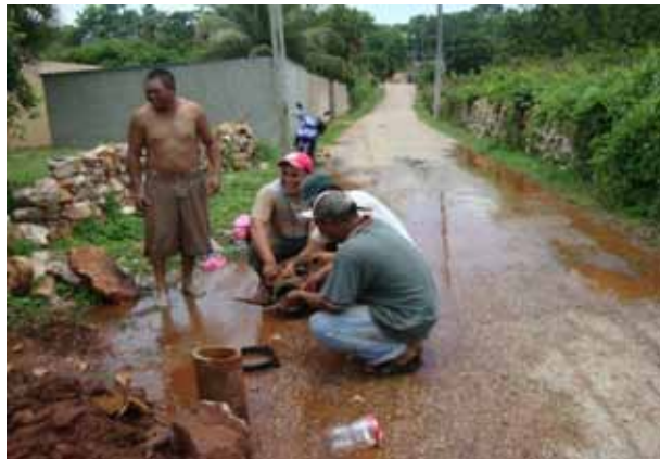
REPARACION DE FUGA EN LA CALLE 49 X 42
