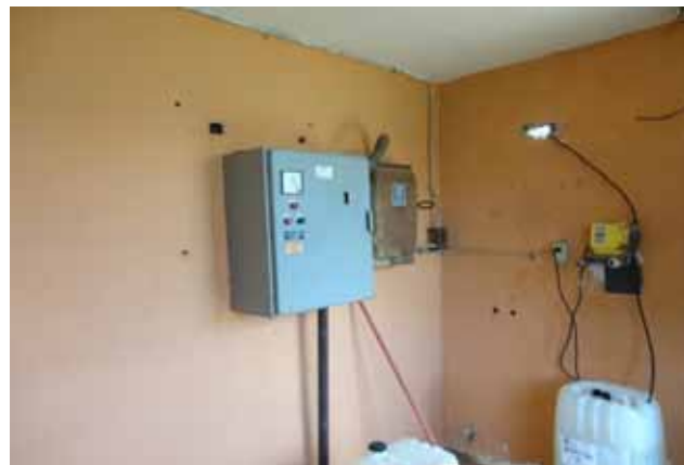
INSTALACION DE UNA LLAVE EN LA COMISARIA DE XOHUAYAN.
