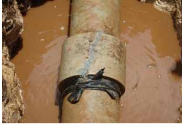
REHABILITACION DE LA BOMBA, MOTOR Y CAMBIO DE TUBERIA DE LA COMISARIA DE XOHUAYAN.
