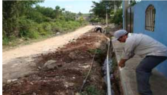
AMPLIACION DE LA RED DE AGUA POTABLE DE LA CALLE 44 X 41 Y 43 (130 METROS)
