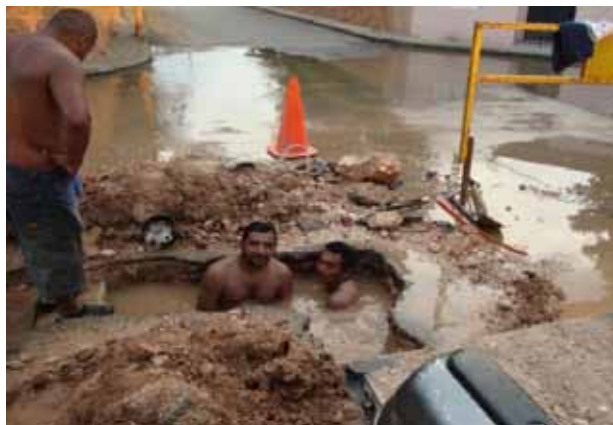
REPARACION DE TUBERIA EN LA CALLE 42 X 33 Y 35
