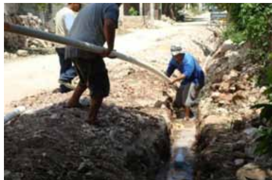
AMPLIACION DE LA RED DE AGUA POTABLE DE LA CALLE 41 X 60 Y 62 (165 METROS)
