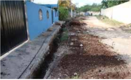
AMPLIACION DE LA RED DE AGUA POTABLE DE LA CALLE 44 X 41 Y 43 (130 METROS)
