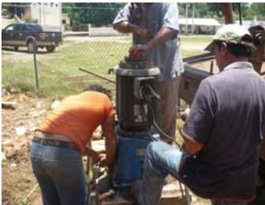
CAMBIO DEL INTERRUPTOR DEL ARRANCADOR DE LA COMISARIA DE XOHUAYAN
