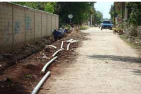
AMPLIACION DE LA RED DE AGUA POTABLE DE LA CALLE 41 X 60 Y 62 (165 METROS)
